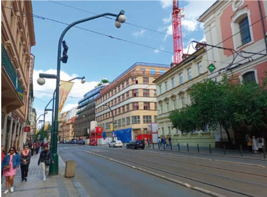
Palác Dunaj v průběhu stavebních prací. Ustupující patro je již vykucháno. Foto: Jan Brejcha, květen 2022.
