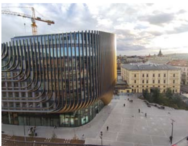
Piazzeta před hlavním průčelím u Havlíčkovy ulice. Foto: Robert Gája, 2023.
