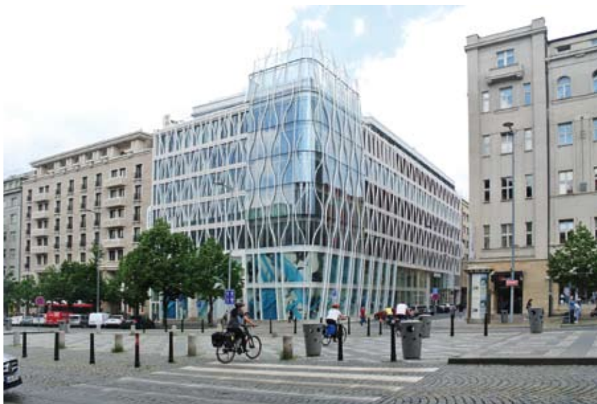
Novostavba Květinového domu. Foto: Kateřina Bečková, 2021.
