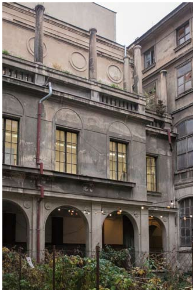
Pohled do vnitrobloku na bývalé východní spojovací křídlo. Foto: Martin Podhola, 2018.
