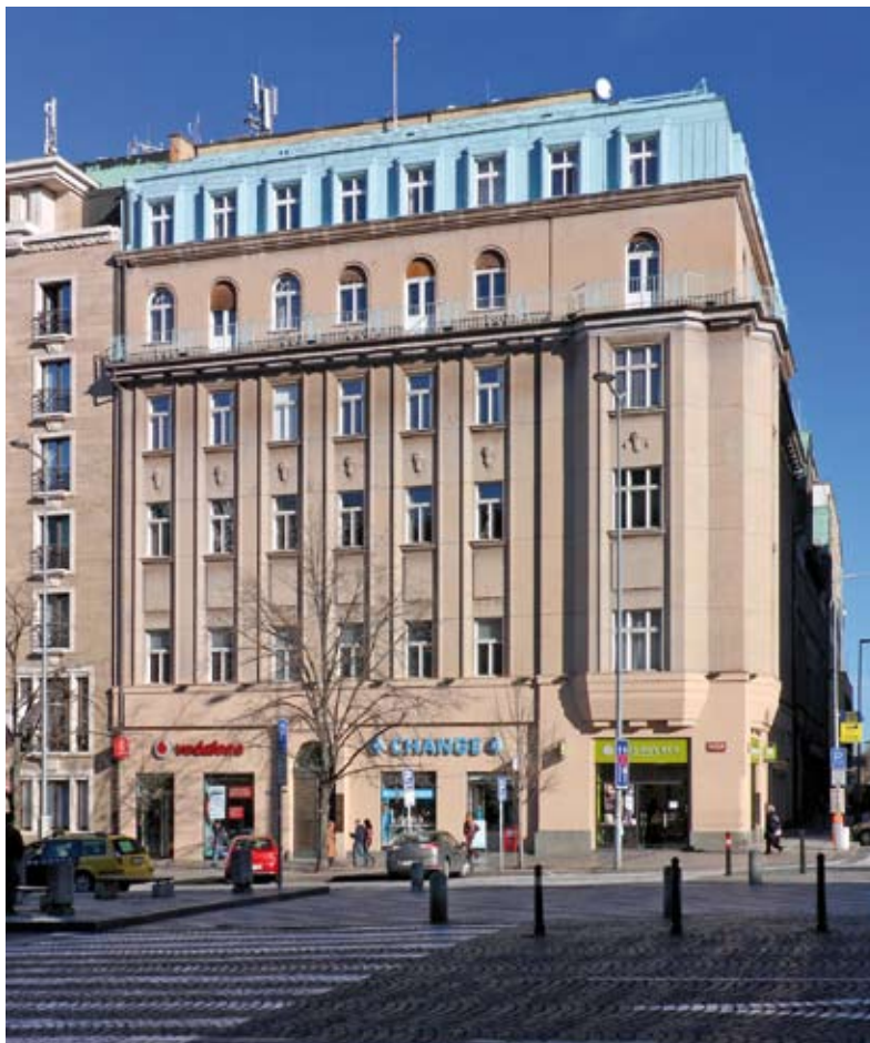
Hodnotná fasáda Kozákova domu v plném slunci. Foto: Lukáš Beran, 2011.
