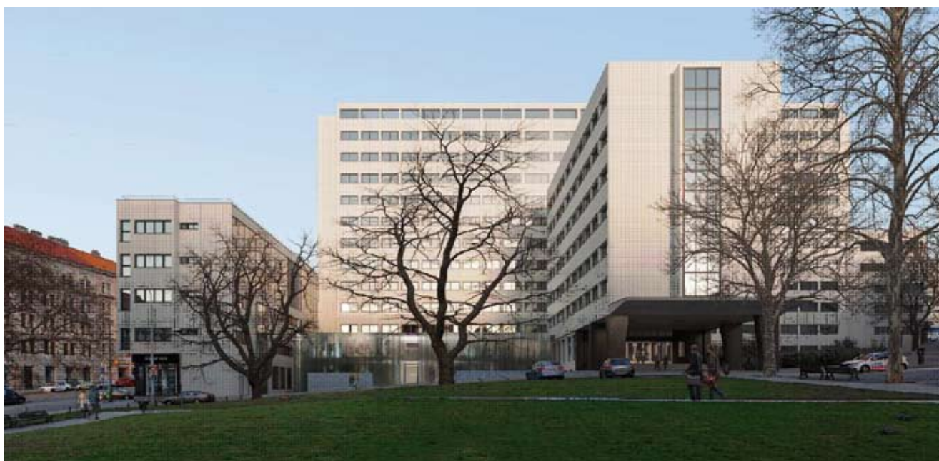
Palác Všeobecného penzijního ústavu, druhá varianta úprav podle projektu ateliéru Qarta, 2021. https://www.qarta.cz/projekty/v-realizaci/dum-radost/ , vyhledáno 16. 4. 2024.
