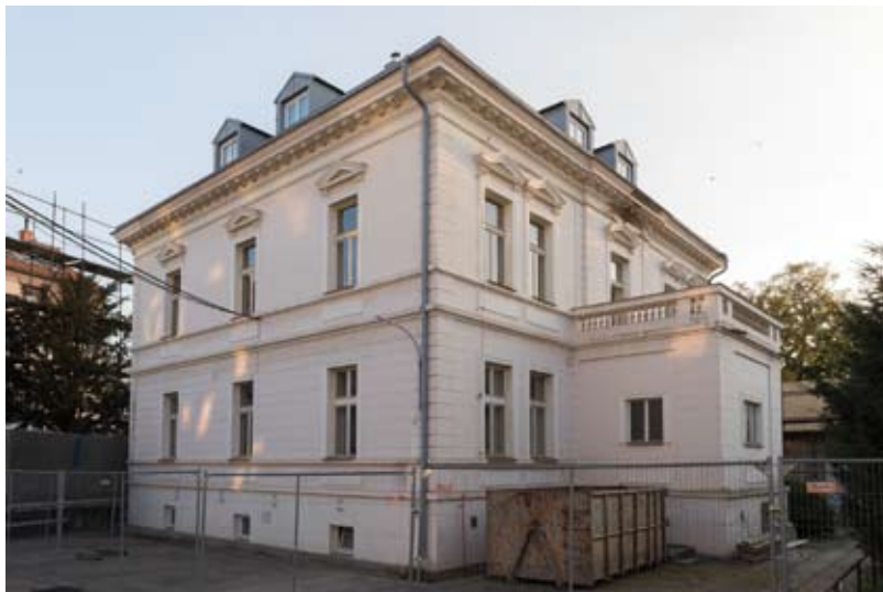
Vila čp. 195 před demolicí. Foto: 2022.
